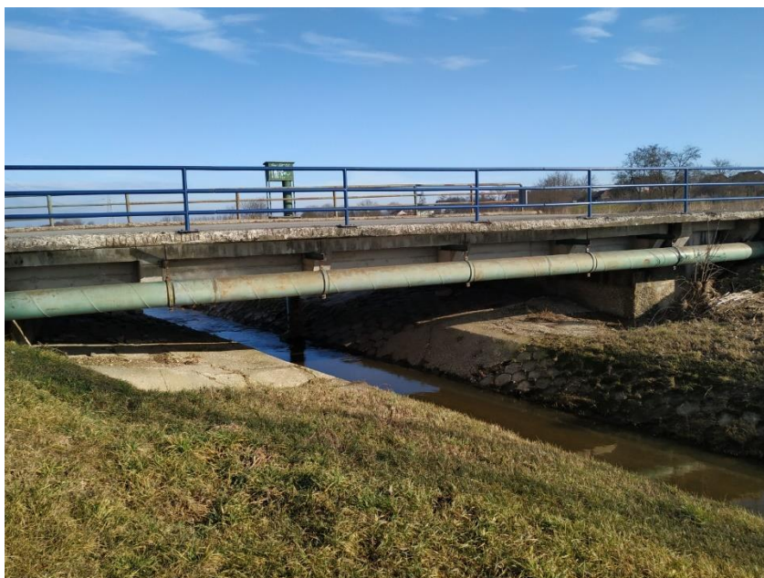
Slika 1.1/3 - Most u Obreškoj ulici (početak dionice)
